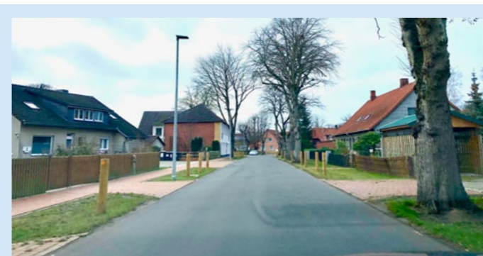
Solide gemacht: Straßenausbaubeiträge abgeschafft und Straßen saniert
